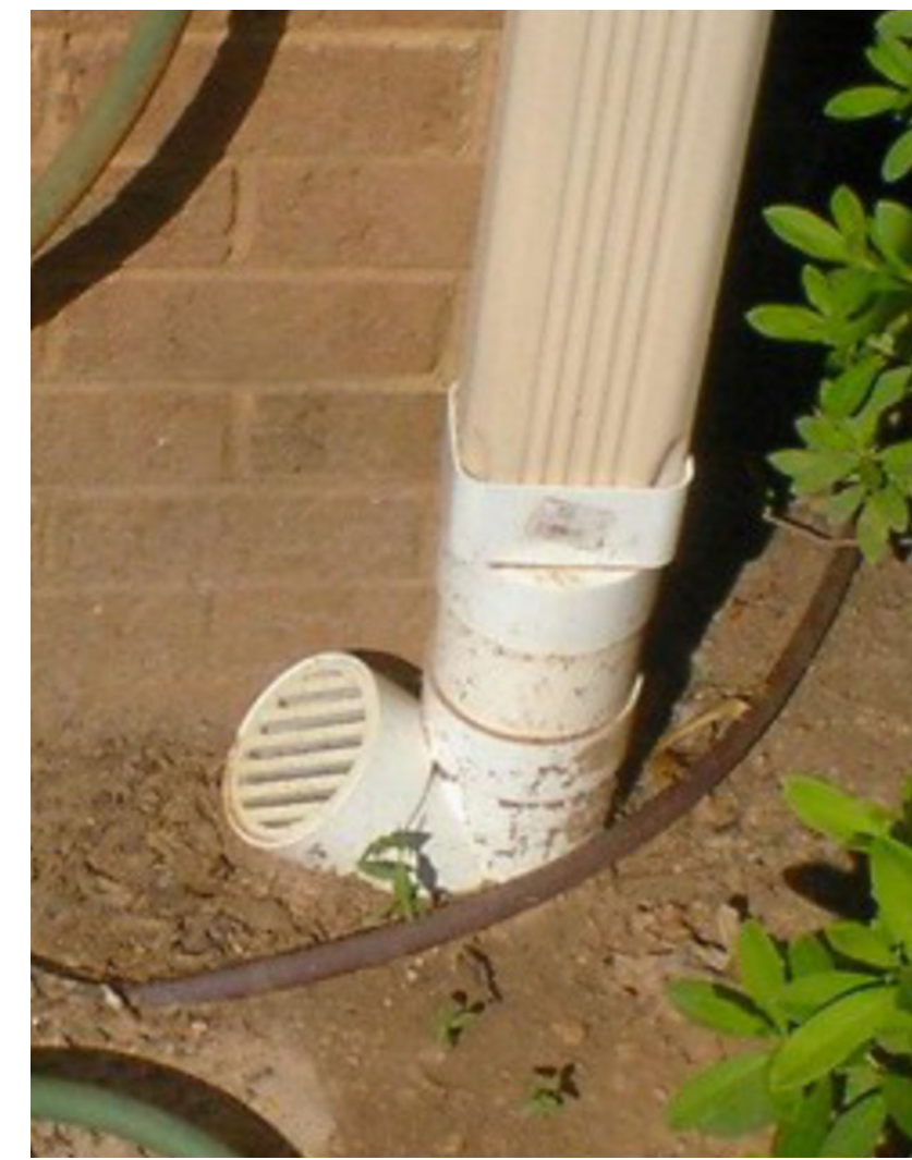
E DOWNSPOUT CLEANOUT C2 N.T.S.
