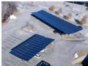
NSHS Solar Canopies
