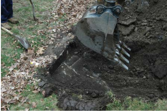
Area 4: excavation of pond edge
