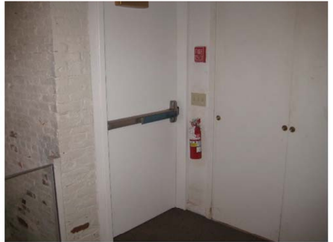
20. Basement Vestibule Door
